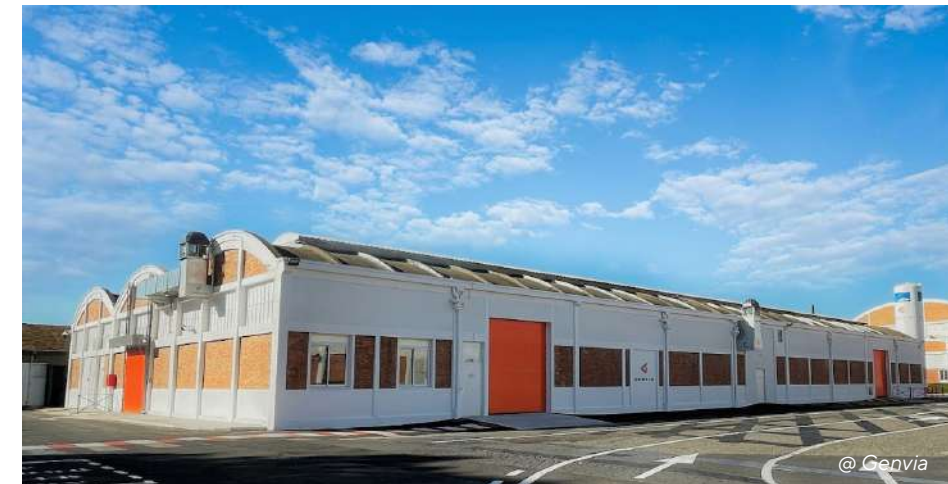
Bâtiment d'usine Genvia, Béziers (34)
