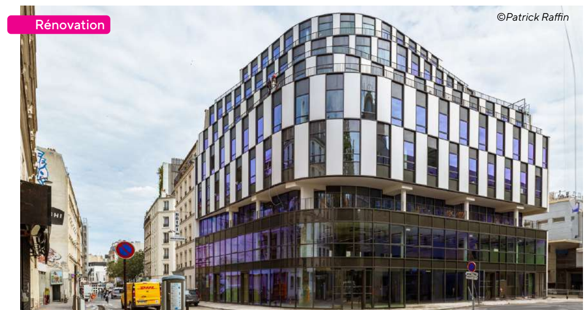
↑ Restructuration et surélévation d'un immeuble de bureaux et de commerces pour PAREF, Paris (75) - SK & Associés
