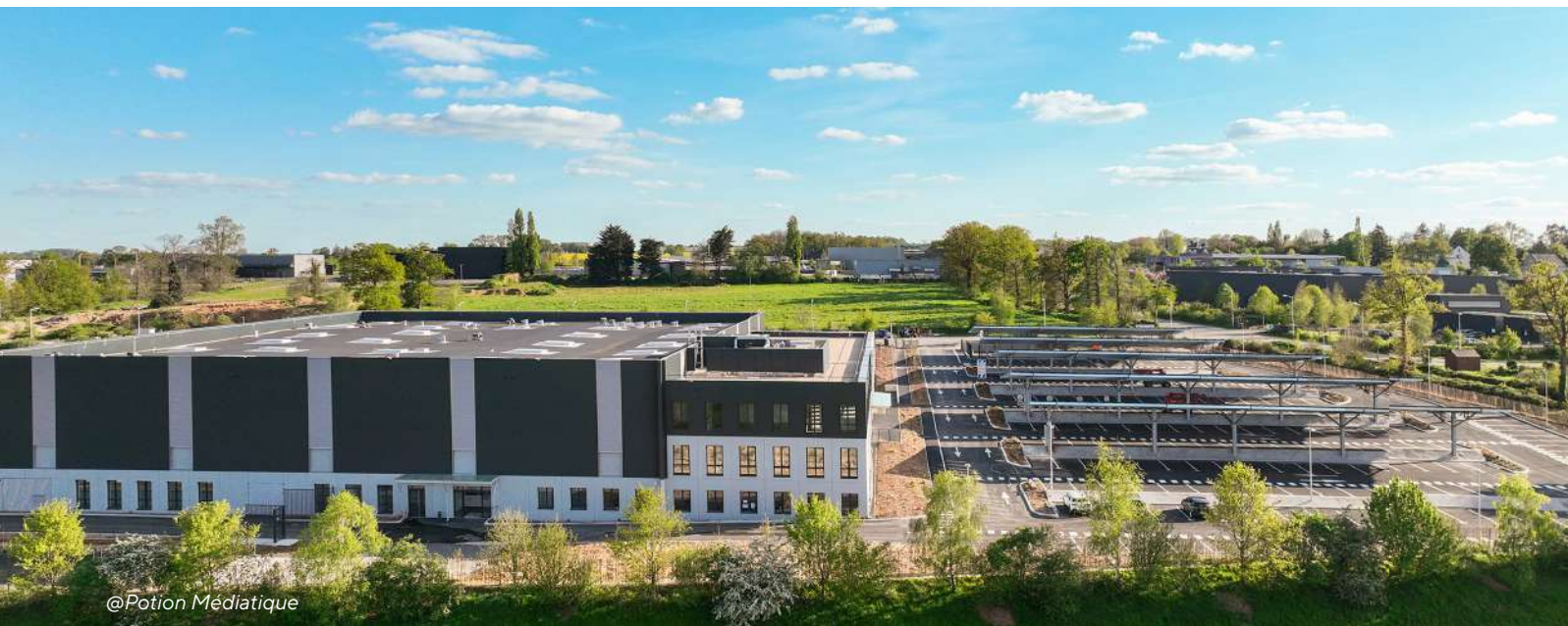
↑ Nouvelle usine de fabrication de cartes bancaires Idemia, Vitré (35) - Sight
