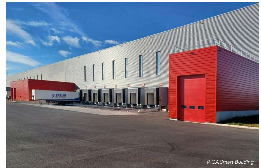
↑ Plateforme logistique du groupe Würth, Montélimar (26) - Sight
