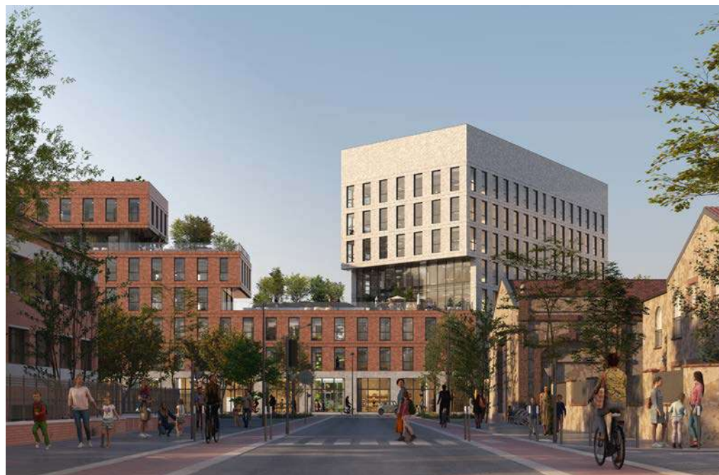
↑ 1pulsion, 1 er immeuble tertiaire de Grand Matabiau Quais d'Oc, Toulouse (31) - Leclercq Associés
