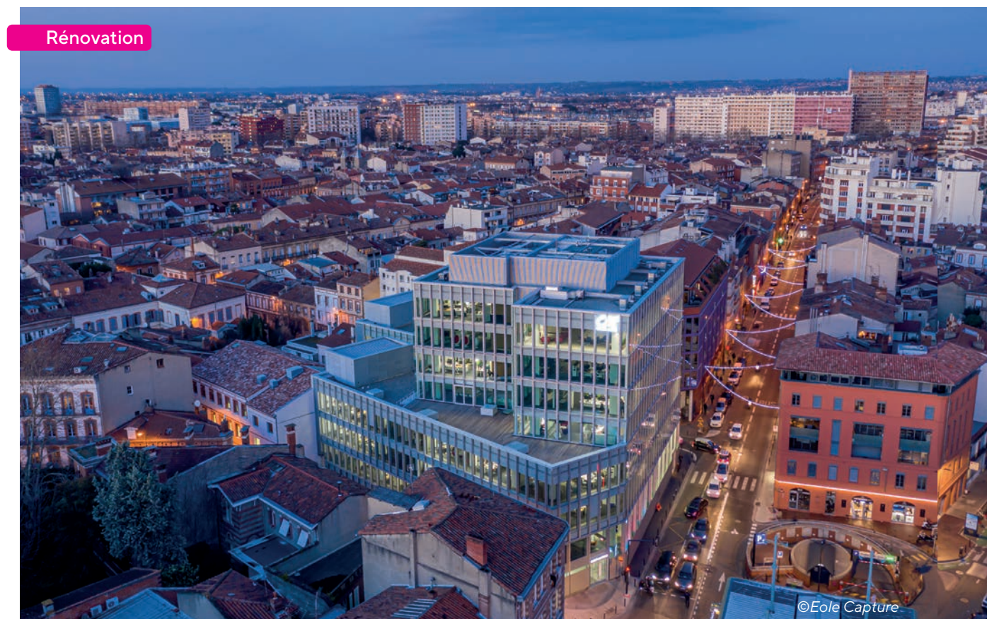
↑ Siège social de Crédit Agricole 31 , Toulouse (31) - PPA Architecture, Scalene architectes et ABC Architecture
