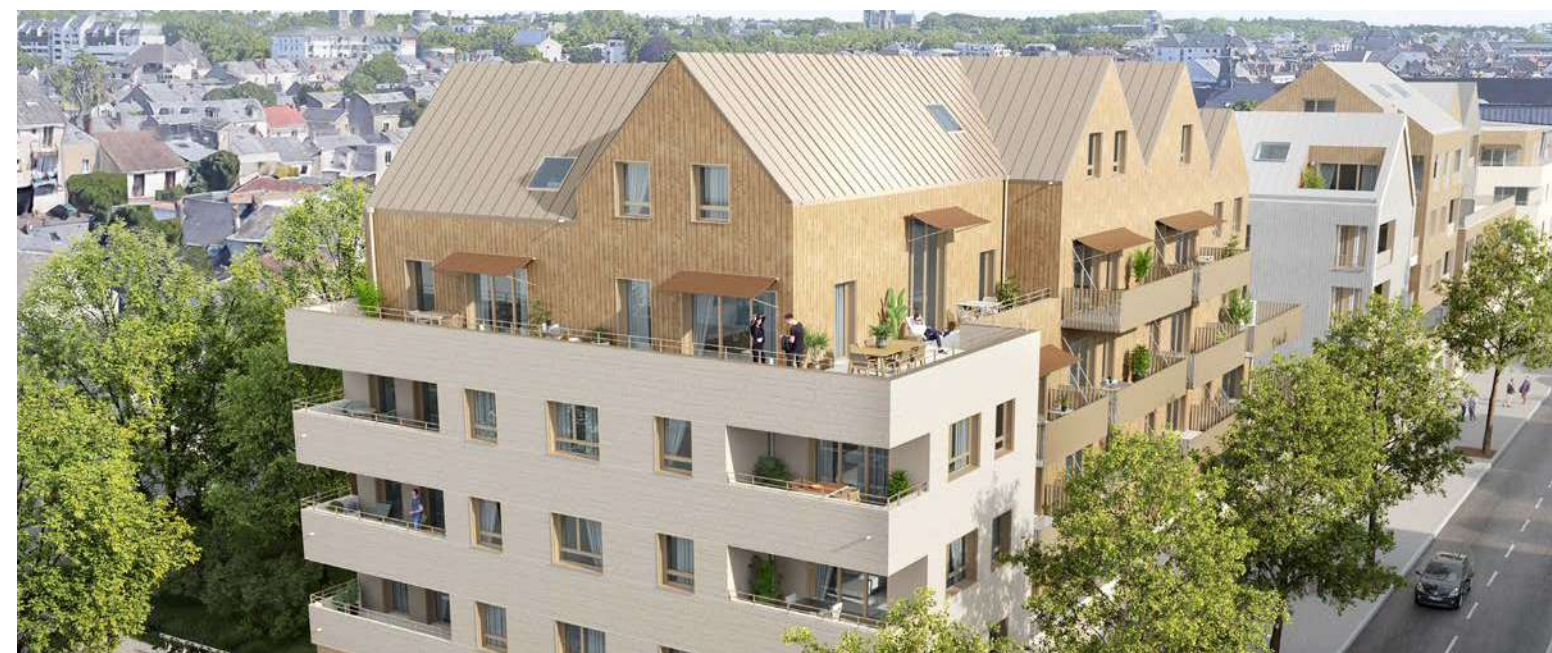
↓ 205 logements, ZAC Casernes Beaumont Chauveau, Tours (37) - D&A + Oslo + RVL
