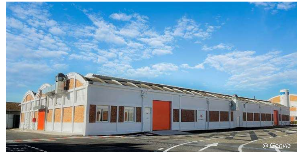
↓ Bâtiment d'usine Genvia, Béziers (34) - Sight
