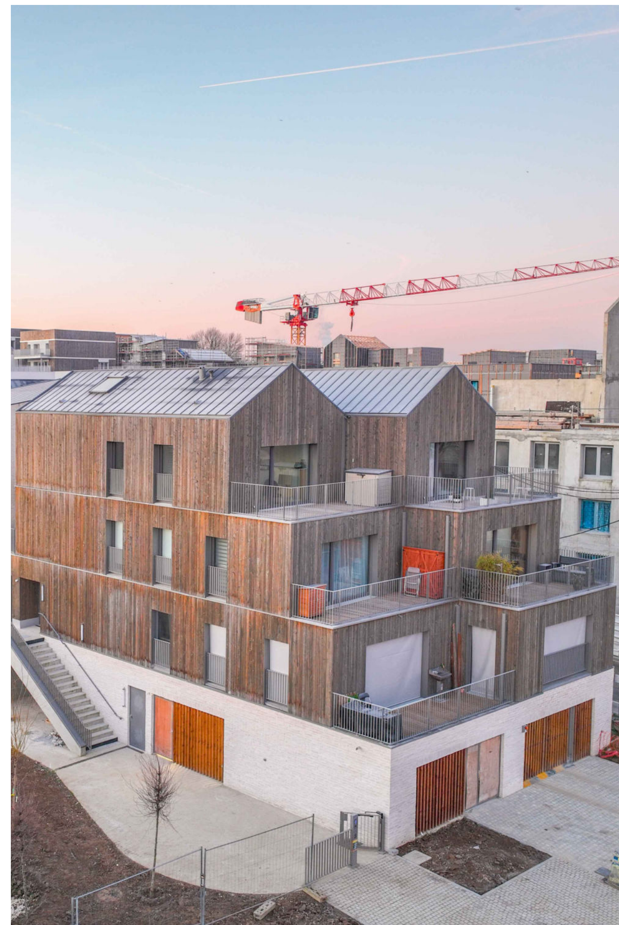
→ Résidence de logements à ossature bois Wood | Like au sein de l'éco-quartier de l'Île de la Marne à Noisy-le-Grand
