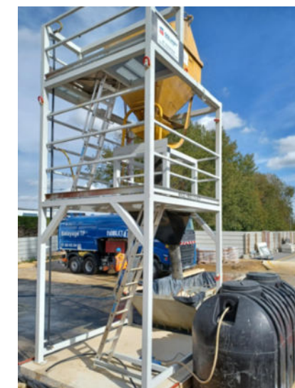
Description : Mise en place d'un circuit fermé pour l'eau de lavage des bennes et des toupies à béton - 13/10/2023 - Chantier DISNEY
